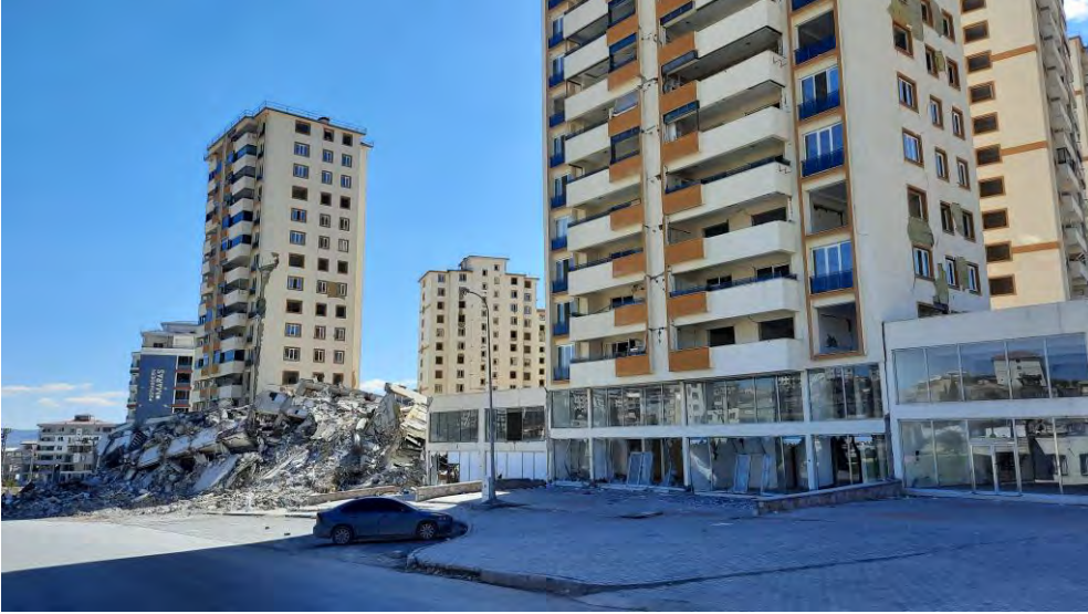
Kahramanmaraş Doğukent'te Yeni Ancak Ağır Hasarlı Durumdaki Yapılar
