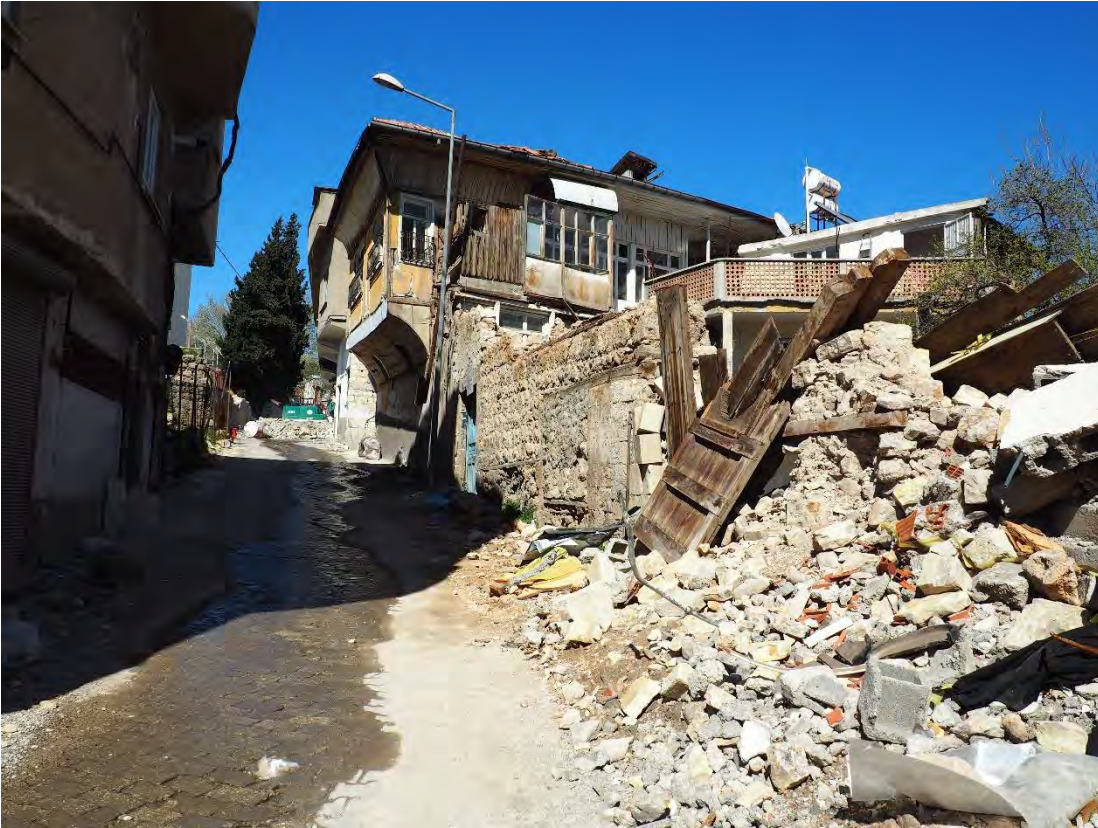
Kahramanmaraş merkez, önde yıkılmış geleneksel yapı, arkada sağlam durumda geleneksel yapı
