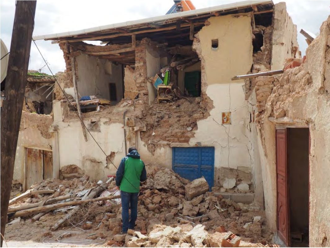
Balaban, üst kat duvarları yıkılmış yapı
