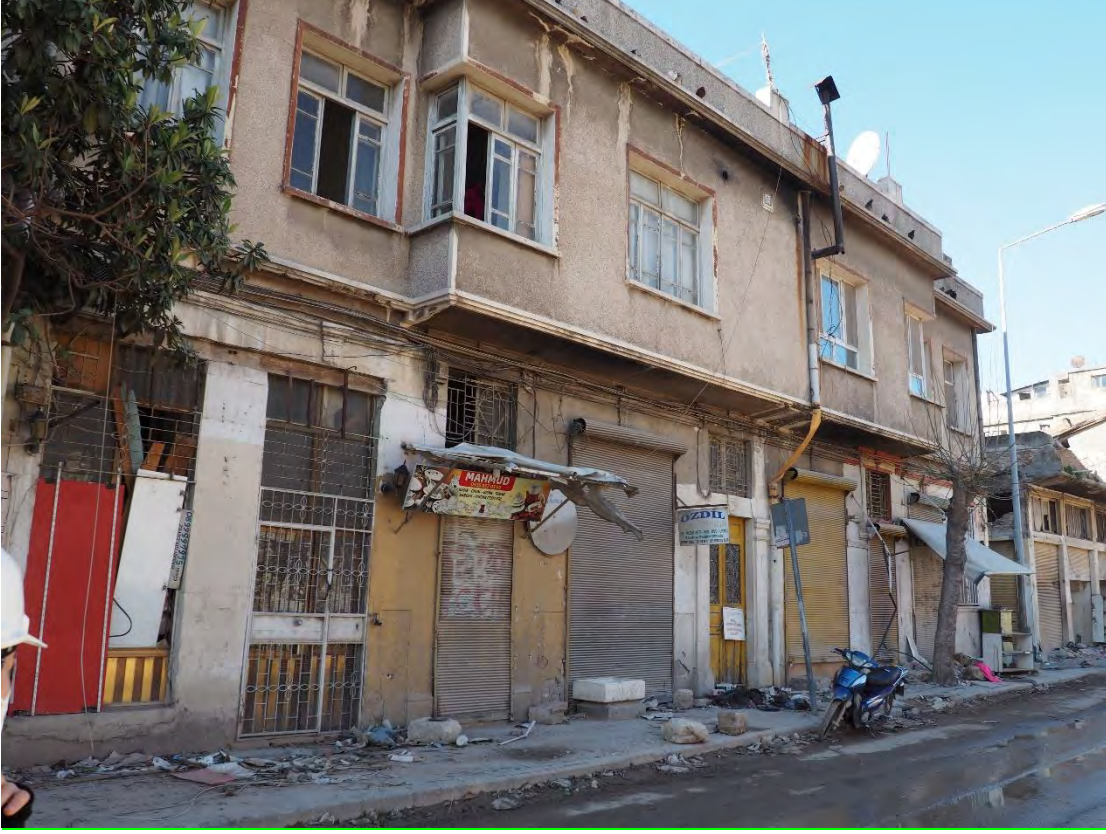
Kurtuluş Caddesi, olasılıkla 1930-40'lı yıllara tarihlenen yığma tuğla duvarlı, betonarme döşemeli yapı
