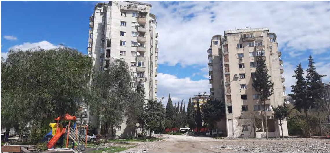
Hatay'da Güçlendirme Yapılan Belediye Blokları
