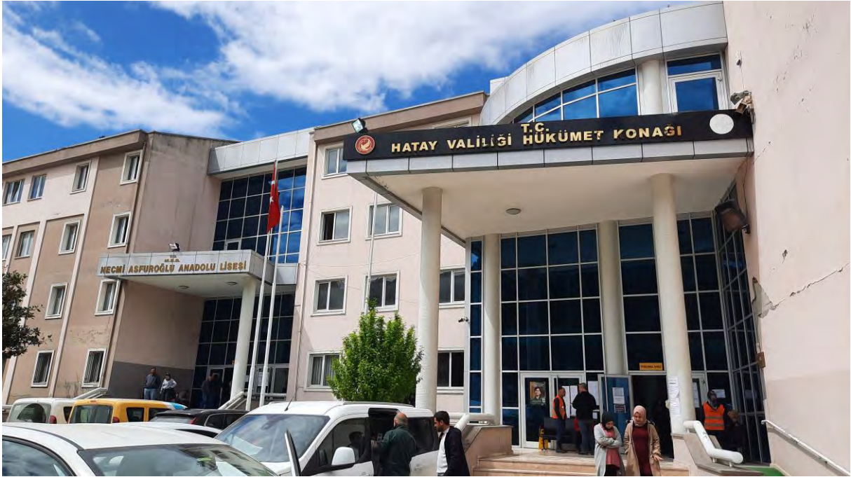
Antakya Valilik - Okul Binası - Necmi Afsuroğlu Anadolu Lisesi
