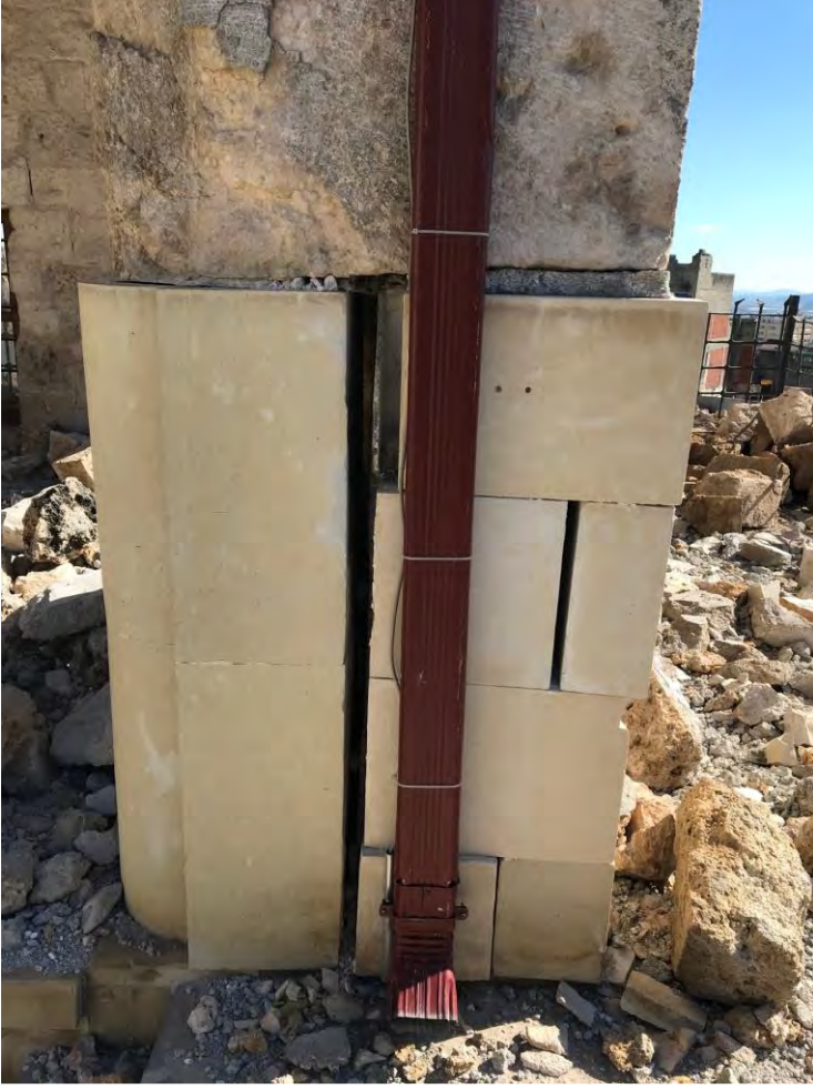
Kahramanmaraş Şekerli Cami, son dönem onarımlarında revak ayağındaki uygulamalar
