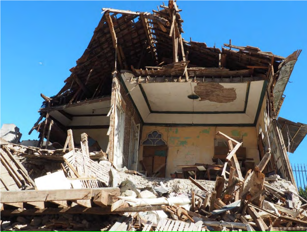
Kurtuluş Caddesi üzerinde yer alan zemin katı yığma taş, üst katı ahşap karkas yapı
