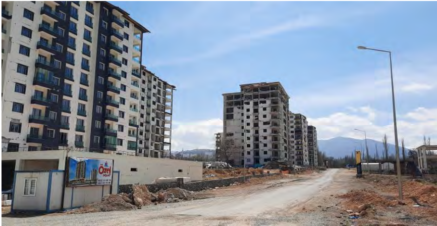
Malatya-Bostanbaşı’nda Yeni Ancak Ağır Hasarlı Durumdaki Yapılar
