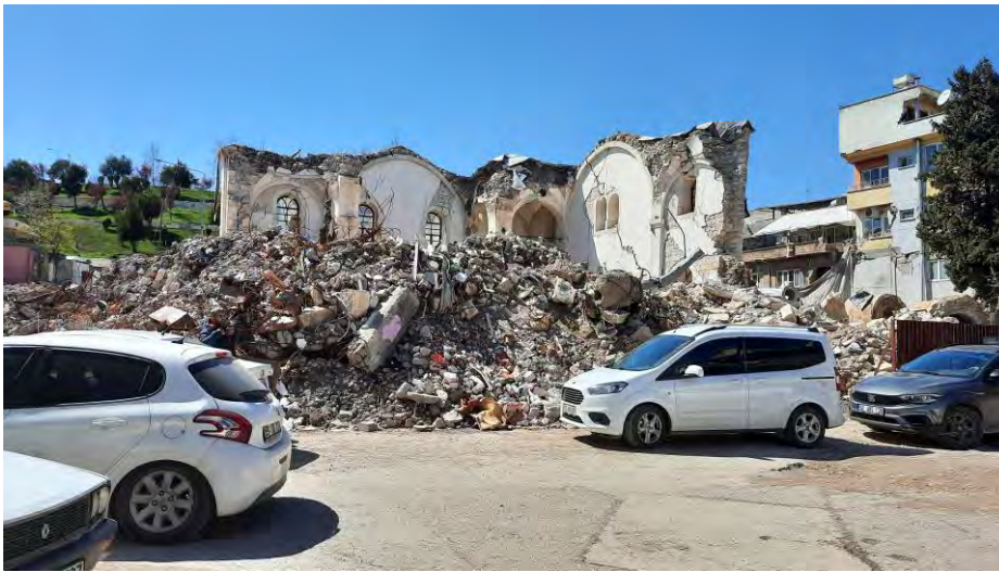
Restore Edilmiş Ancak Yıkık-Ağır Hasarlı Durumda Olan Yapılar, Adıyaman
