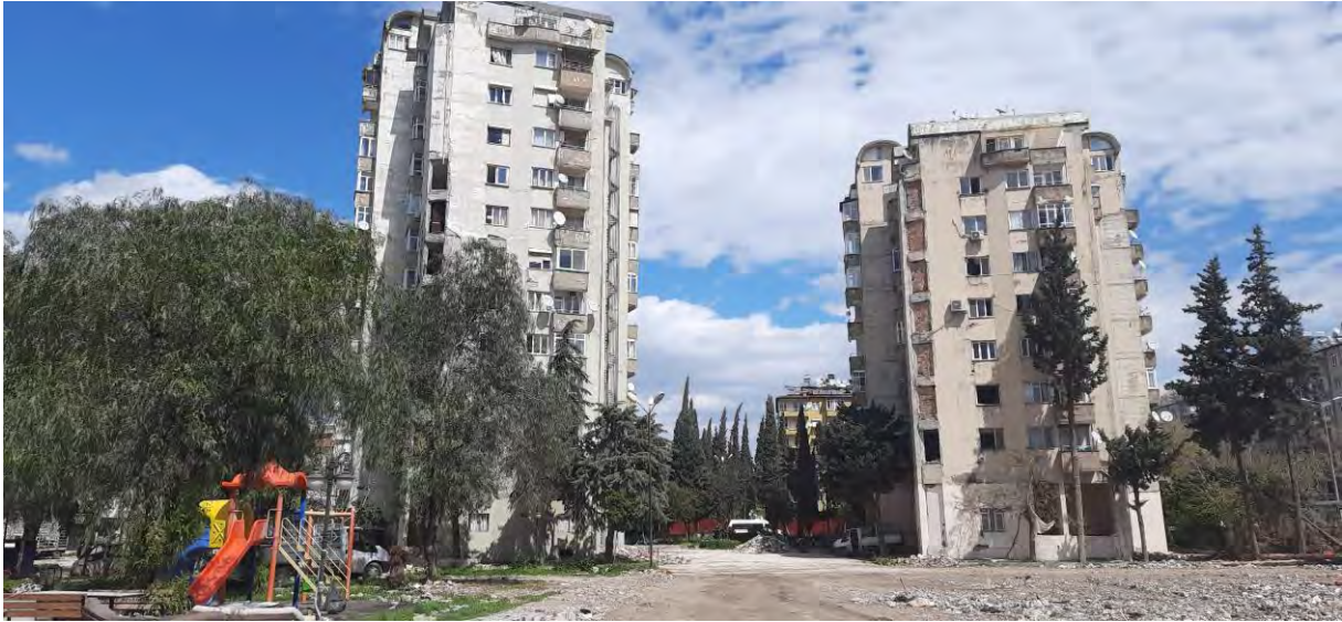
Hatay'da Güçlendirme Yapılan Belediye Blokları
