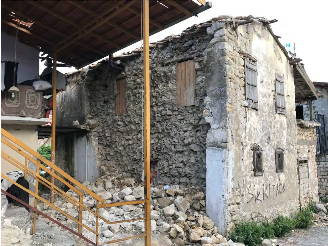
Hatay, Samandağ İlçesi, Hıdırbey Köyü'ndeki sivil mimari örneklerinde kagir duvarlarda görülen hasarlar
