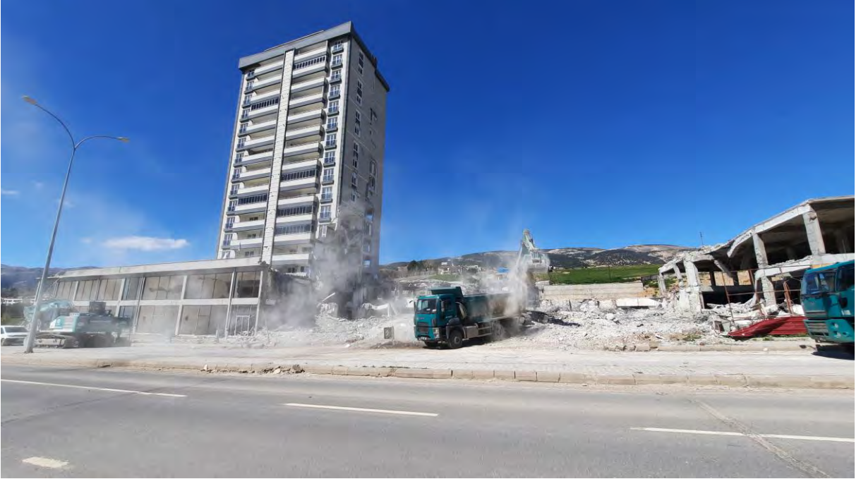
Badı Saba Sitesi Yıkımı
