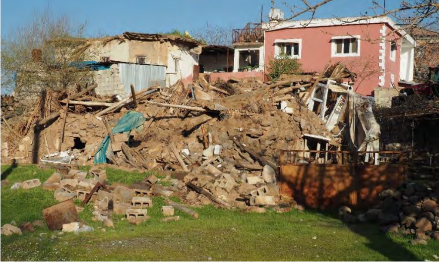
Gaziantep, Islahiye İlçesi, Zincirli Köyü, yıkılmış taş yapı
