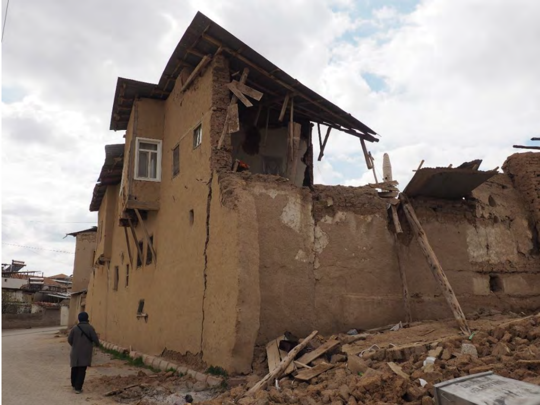
Balaban 2023; Deprem sonrası bir evin görünümü
