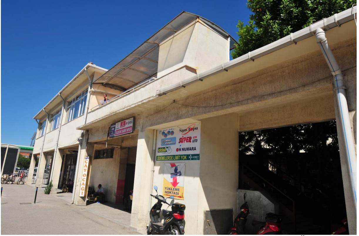
Eski Otogar Binası ile Hizmet Binası Arasında Kalan Bölümün Ön Cephesi
