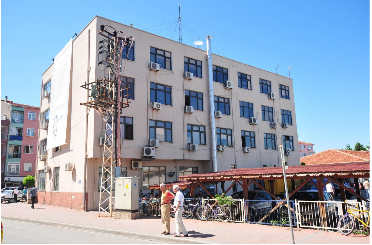
Mevcut Hizmet Binasının Arka Cephesi
