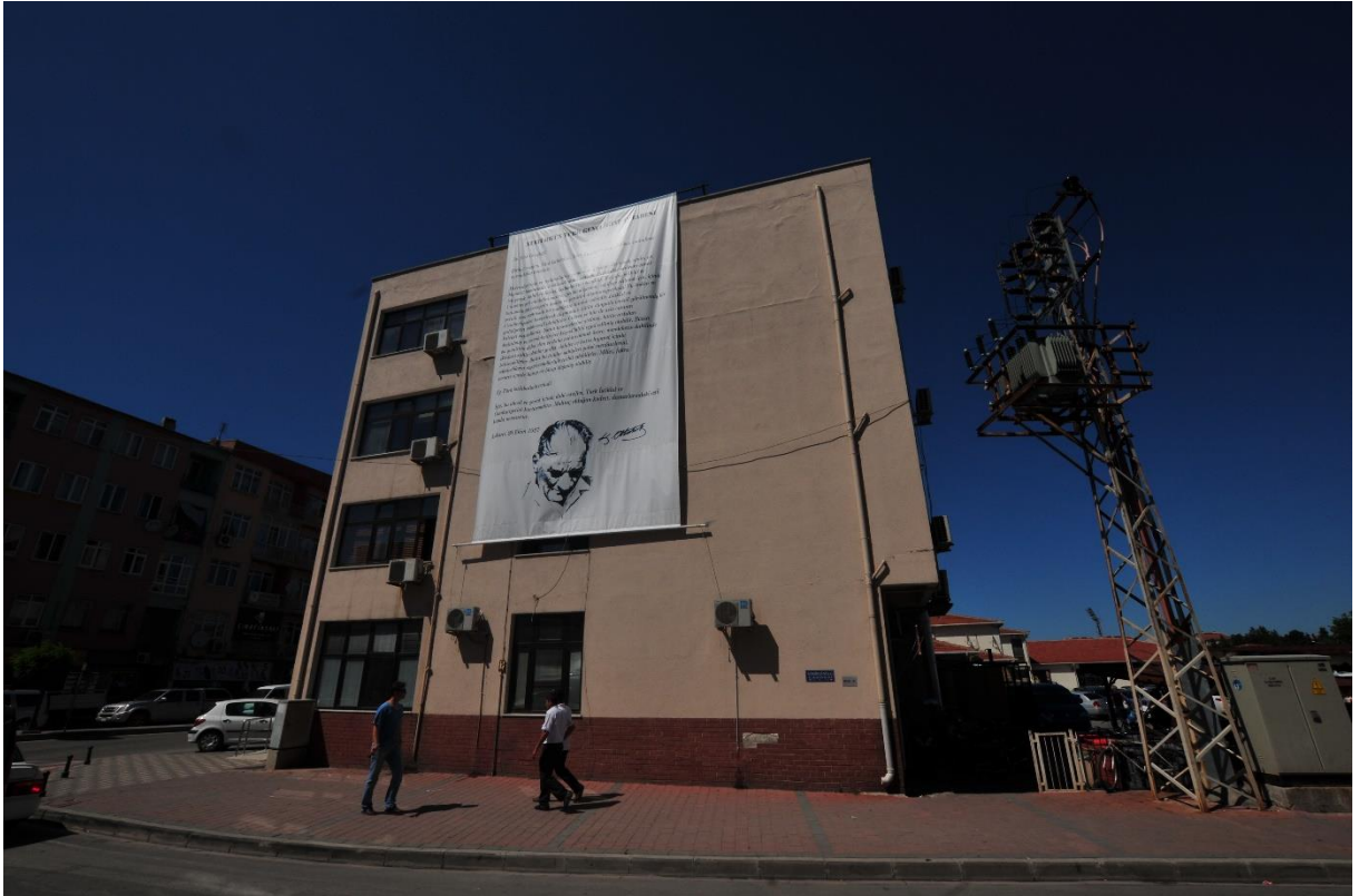
Mevcut Hizmet Binasının Sağ Yan Cephesi
