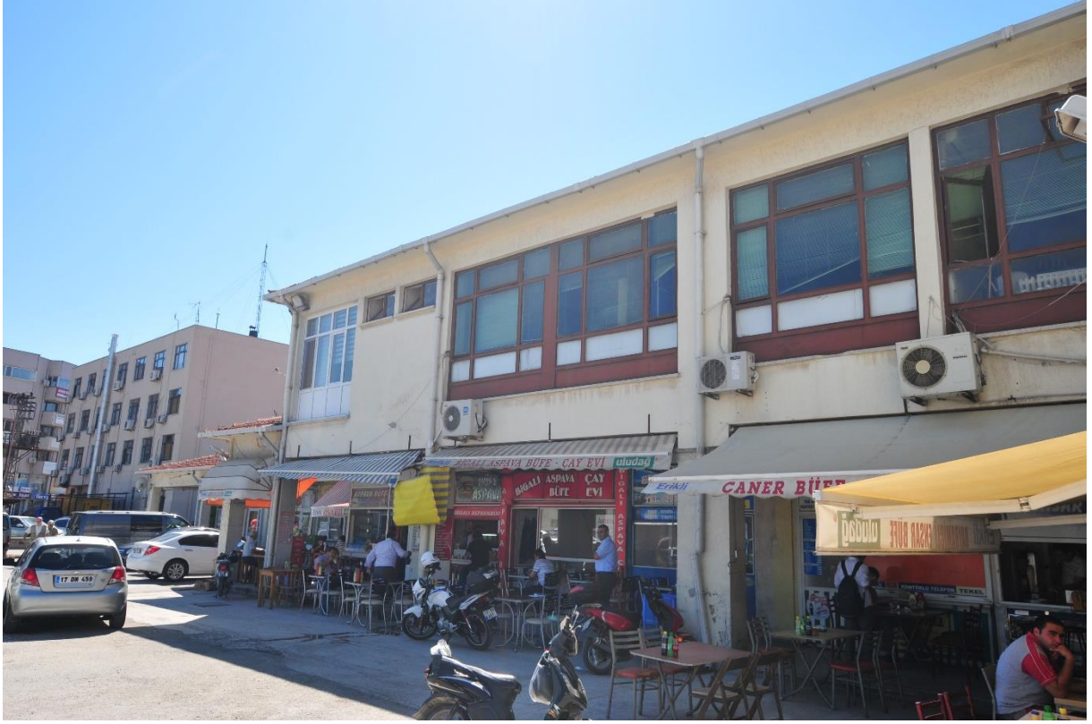
Eski Otogar Binasının Arka Cephesi
