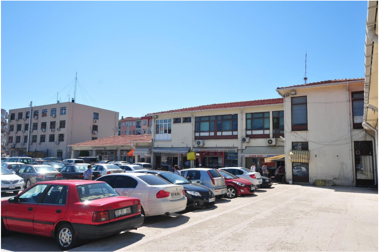
Eski Otogar Binasının Arka Cephesi
