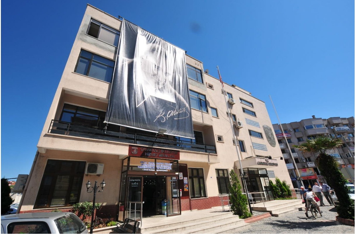
Mevcut Hizmet Binasının Ön Cephesi
